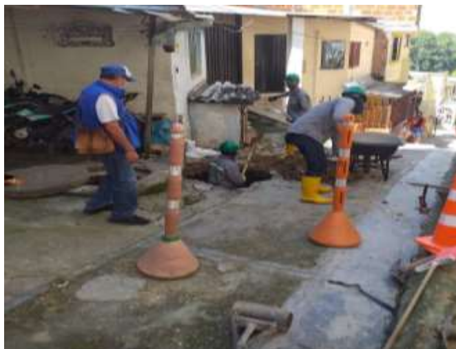
Quebrada Aranzoque y alcantarillado del Barrio "Primavera II", septiembre 15 de 2021
