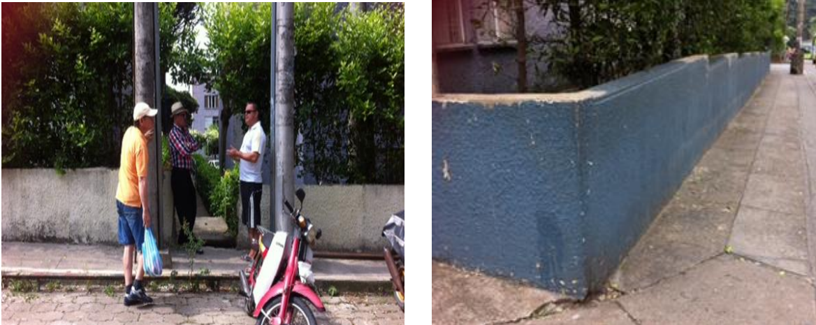
Conjunto Multifamiliar Bucarica Sector 19.
